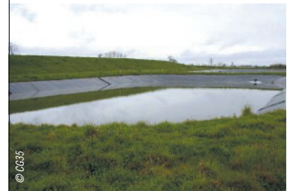
Etanchéité par géomembrane.
