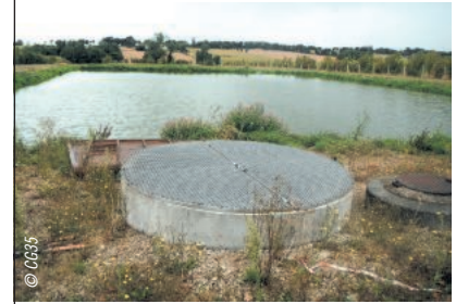
Piège à boues en bord de bassin.
