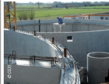
Evolution du système d'assainissement de la Fresnais (modification de la filière d'épuration) : ancienne station par lagunage, nouvelle station en chantier par procédé boues activées.
