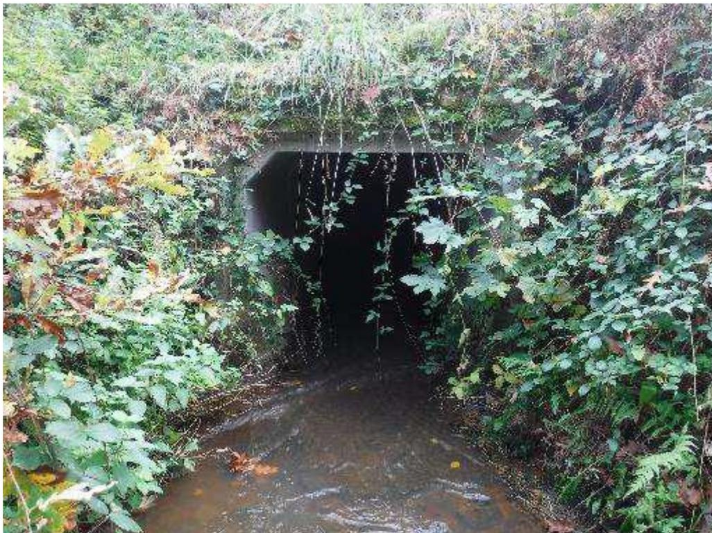
Pont cadre du ruisseau de la Moutte – RD 40 avant débroussaillage et installation de la banquette en encorbellement.
