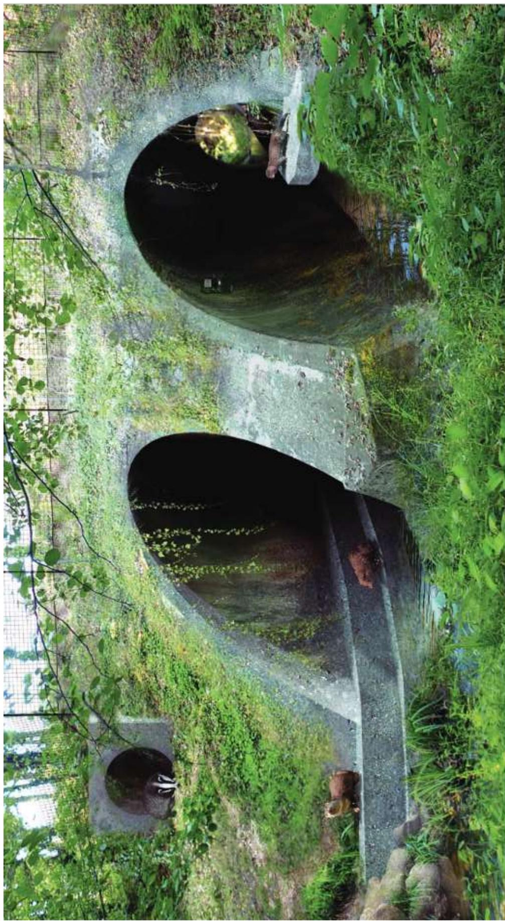
Photo n°4 : 3 types d'aménagement rétablissant les continuités écologiques : écoduc, banquettes et encoffrement (de gauche à droite). (© VINCI Autoroutes, L'Annexe)
