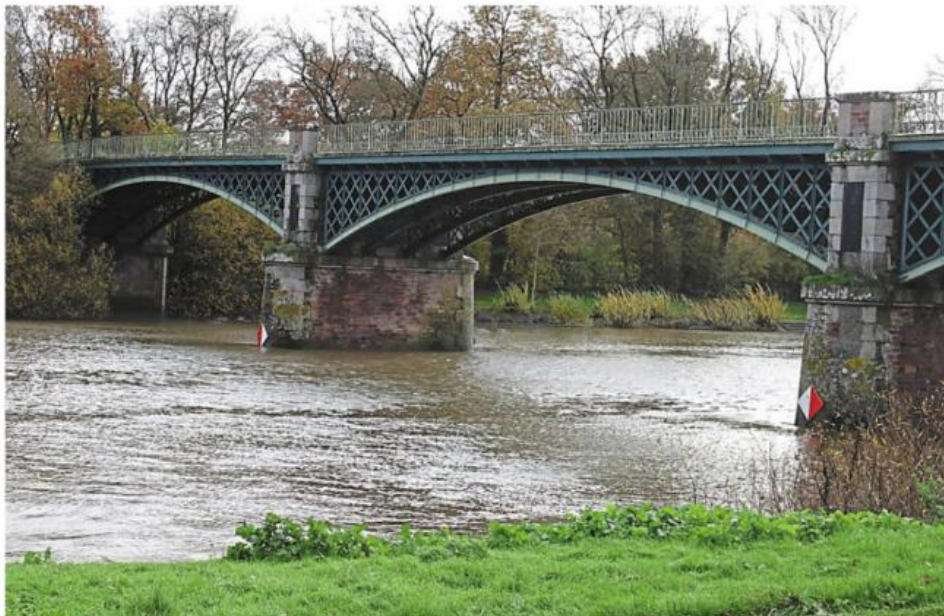
Le pont de Port-de-Roche, à Langon, a été construit pour l'exposition universelle de Paris, en 1867. PHOTO : ARCHIVES OUEST-FRANCE
